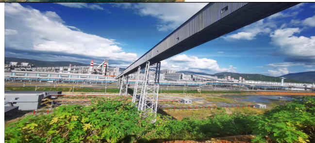
炉渣皮带输送廊道
