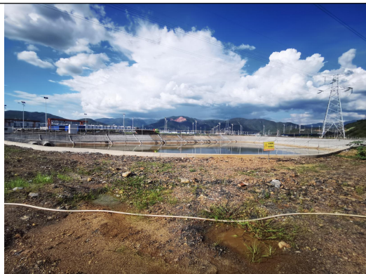
初期雨水收集池
