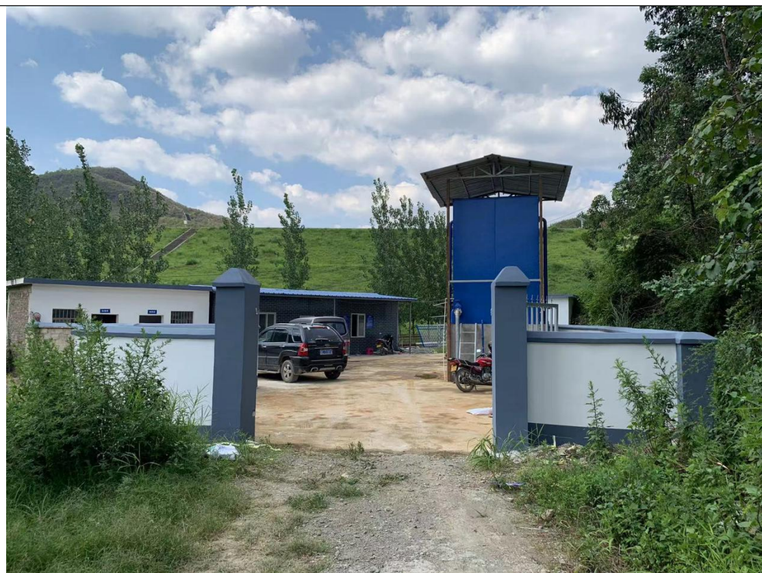
回龙水厂现状
