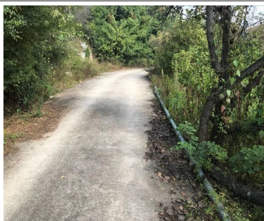
甸中镇集镇供水配水管网现状
