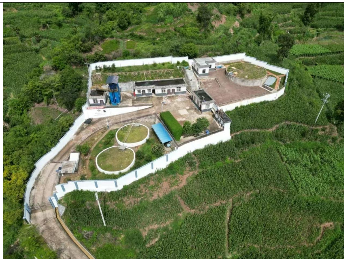
岔河乡水厂现状
