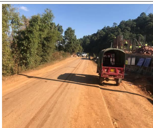
乃邑水库人饮供水工程配水管网现状
